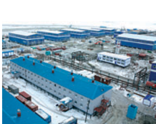
Новая База бурения на Бованенковском НГКМ.
